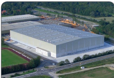
Inauguration du bâtiment de montage des engins de manutention
